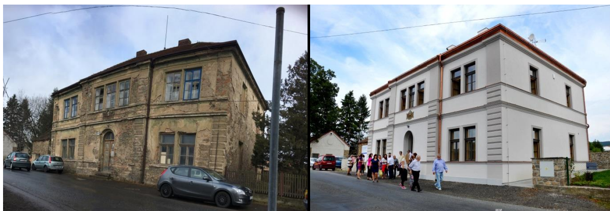
Obrázek: Před a po rekonstrukci budovy Fara v obci Obecnice
