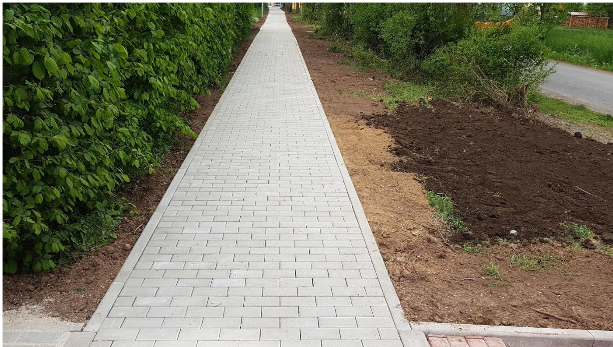
Obrázek 20 Chodník II. etapy v obci Suchodol – napojení severní části
